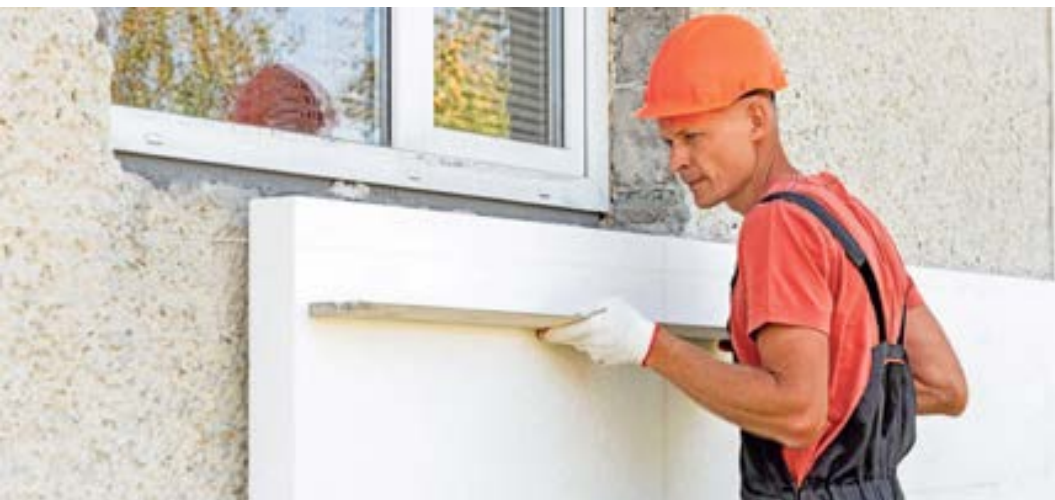
Die Heizkosten spürbar eindämmen: Eine Fassadendämmung lohnt sich dauerhaft – und wird zudem finanziell weiterhin gefördert. Foto: djd/IVH/Getty Images/yunava1
